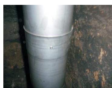
V případě požadavku na vyšší komín je vložkování možné kombinovat s nerezovým izolovaným nástavcem. Dosáhne se tak požadované výšky pro správný tah spotřebiče.
